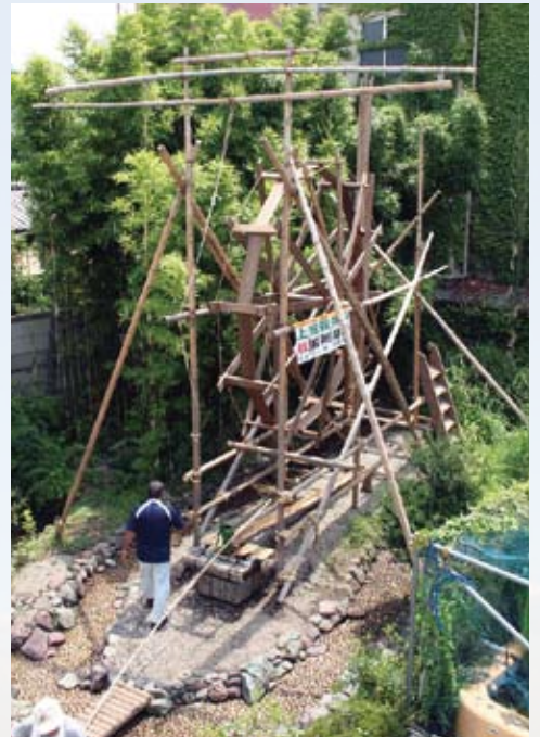
地域住民の手による井戸掘り
