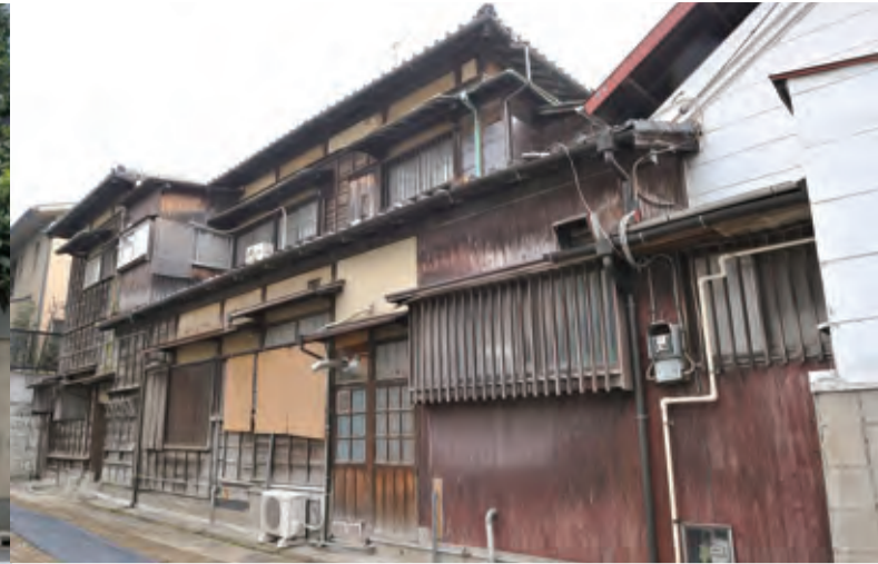
間口約5m、奥行約18mというボリュームで、隣地の空き地(2014年2月現在)からの、古色蒼然とした下見板張りの外観に目を留める人も多いだろう。
