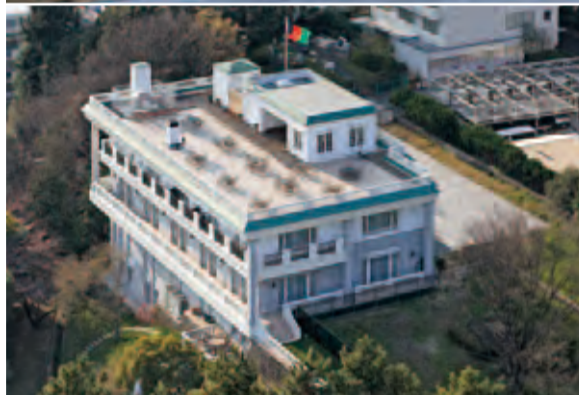
正面側が地上2階と屋上塔屋、裏手に回ると執務室など地下2階部分が現れる実質4階建ビル。塔屋の向こう端（国旗ポールあたりに）小さなドームが見える（2008年撮影）。写真提供:アフガニスタン大使館
