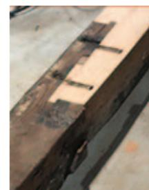
新旧の材を金輪継ぎで組んだ断面。柱の根本に使われ、前後左右に力がかかっても、変形に追従し柔軟に元に戻る。
