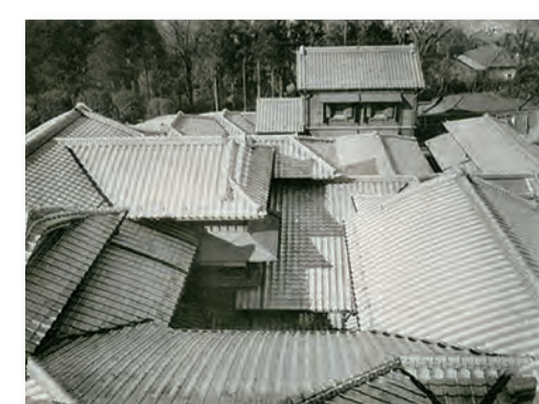
洋館より日本間屋上を望む
