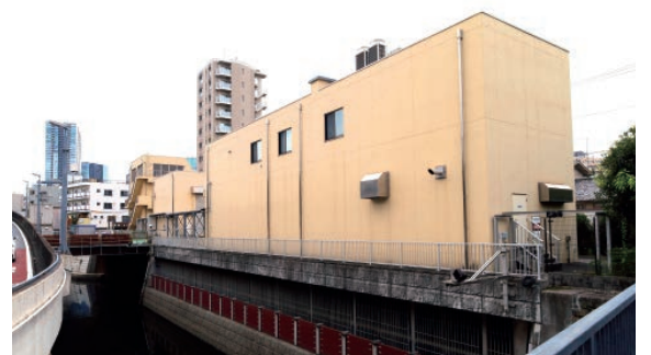
取水施設外観
