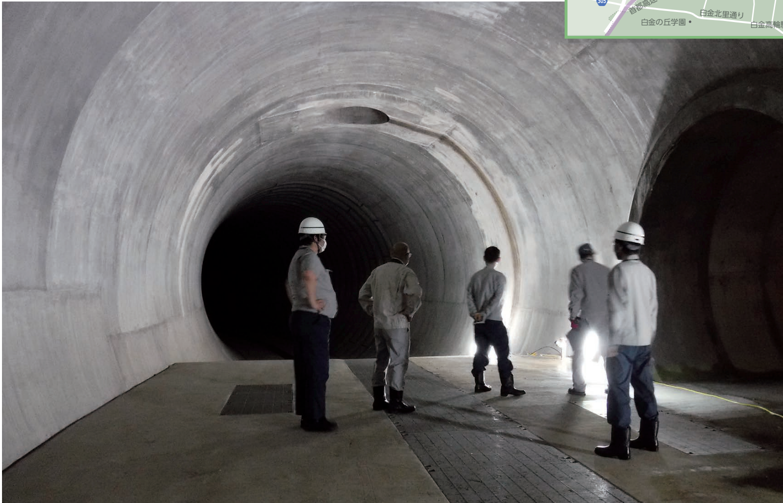
調節池トンネル内の様子
