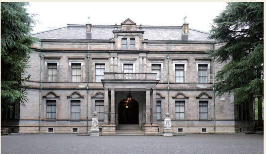
現在の開東閣の外観
