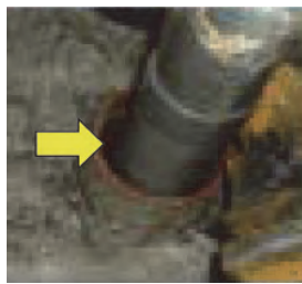
外壁の貫通口 (エアコン、キッチンの給排水・ガスの配管、配電盤など)
