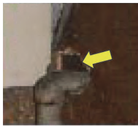
外壁の貫通口 (エアコン、キッチンの給排水・ガスの配管、配電盤など)
