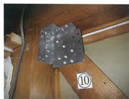
梁や柱と筋かいを固定します
