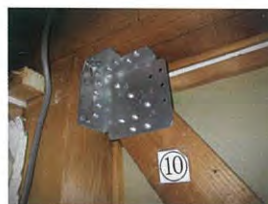
梁や柱と筋かいを固定します
