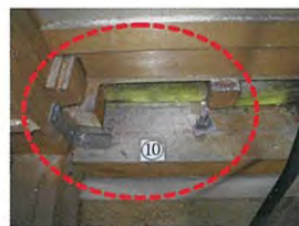
柱と土台を固定します
