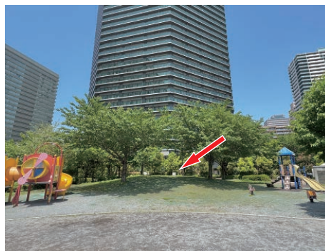
地面の中ほどが少し盛り上がっていますが、その下になんと水が貯められています
