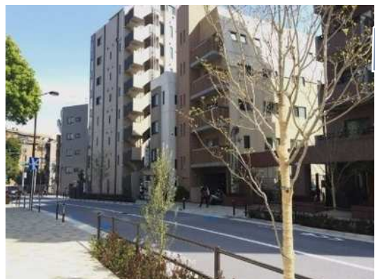
写真4-1 都市計画道路補助線街路第7号線
