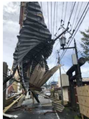
写真1-2 令和元年房総半島台風の被害状況 (出典：東京電力パワーグリッドホームページ)
