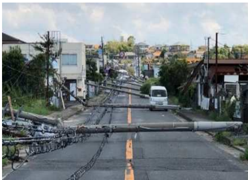
写真1-1 台風による電柱の倒壊状況 (出典：国土交通省ホームページ)
