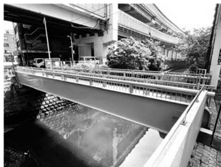
新堀橋（工事完了後）
