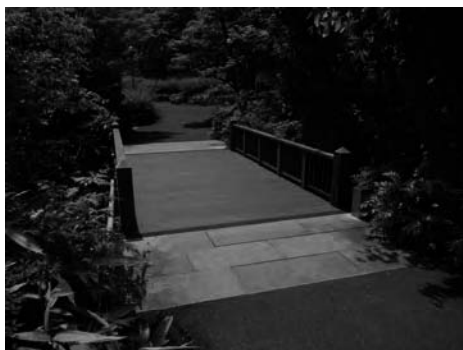
檜町公園 公園橋架替
