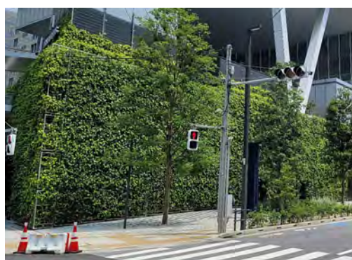
▲壁面緑化（虎ノ門ヒルズステーションタワー）
