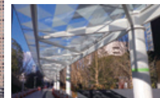
外構工事の様子（2月下旬）
