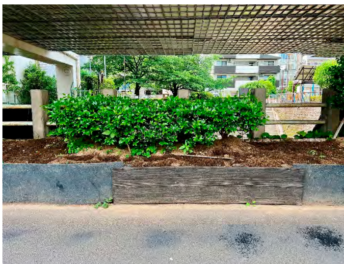
古川沿緑地 木杭補修
