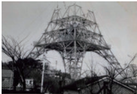
建設中の東京タワー（提供：TOKYO TOWER）
