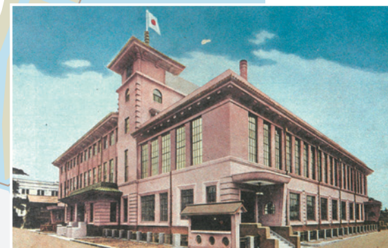
芝区役所 (出典:『東京都港区旧庁舎記録保存集 概要・写真・図面』)
