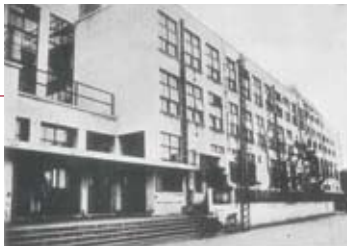
中之町尋常小学校 昭和8年(1933)落成の鉄筋校舎。／赤坂区史
