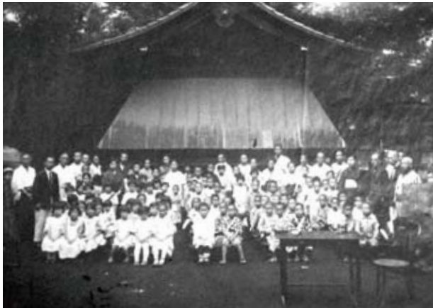
「赤坂小学校早起会」赤坂氷川神社境内での、赤坂小学校早起会の集合写真。子どもたちの後ろに見えているのは、戦時中まで建っていた神楽殿の屋根です。現在のお祭りでは、ここに盆踊りの櫓が組まれています。境内には、神楽殿の礎になった石の遺構が今も残されています。／取材提供写真
