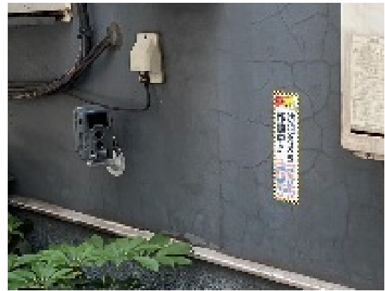
防犯カメラ設置の状況
