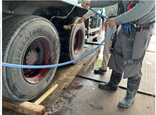
写真4.1.1-4 タイヤ洗浄状況
