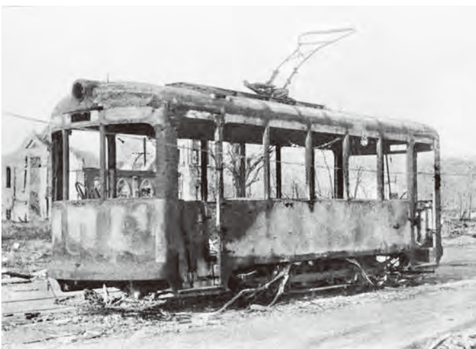
広島・八丁堀付近の電車通りで被爆し、全焼した路面電車（提供：共同通信社）
