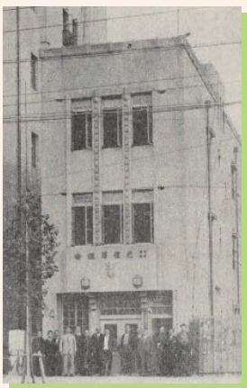
昭和2年(1927)に新築した3階建ての田村町本店
