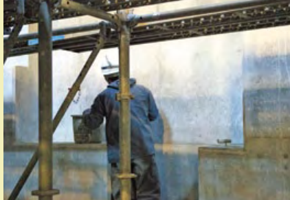
写真③ 消火設備用場所の工事
