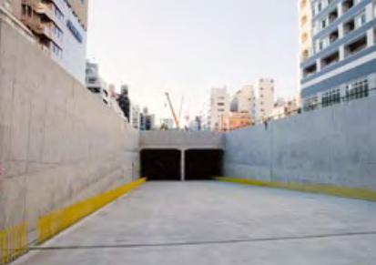
写真④ 新橋方面ランプ出入口
