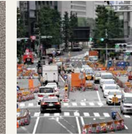
新駅設置工事が急ピッチで進んでいる桜田通り
