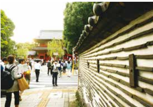
土と瓦を交互に積み上げて壁体とする構造の練堀
