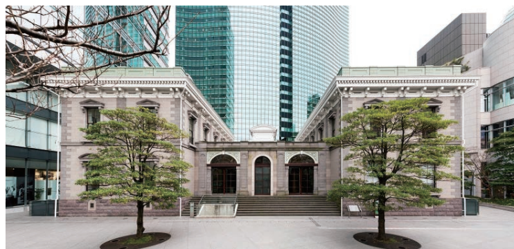
再現された駅舎正面外観
