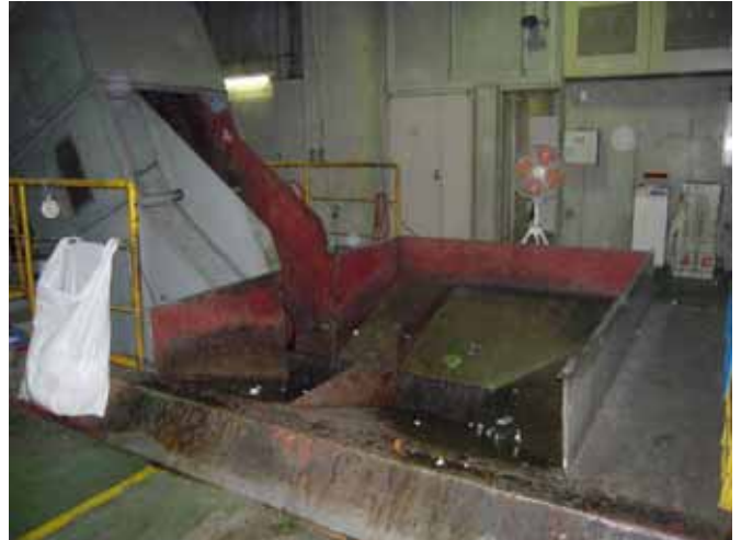
かん圧縮機 投入口
