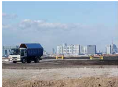
覆土された埋立地
