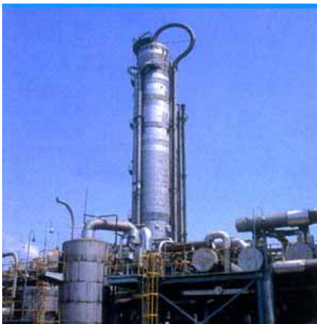
アンモニア製造設備
