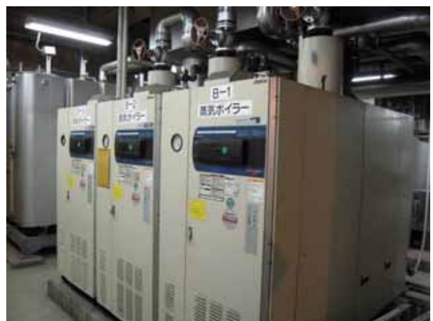
蒸気ボイラー制御設備
