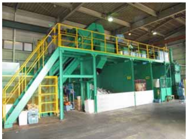
処理設備 全景
