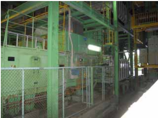
コンテナへの圧縮投入機
