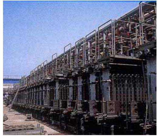
ソーダ電解設備
