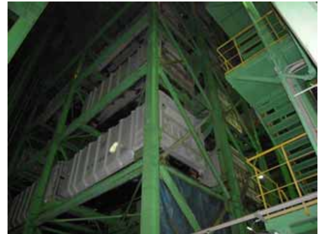
コンテナ保管設備
