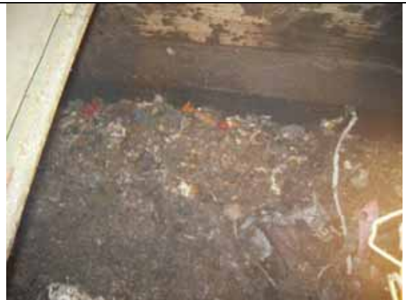
ベルトコンベア内の不燃ごみ
