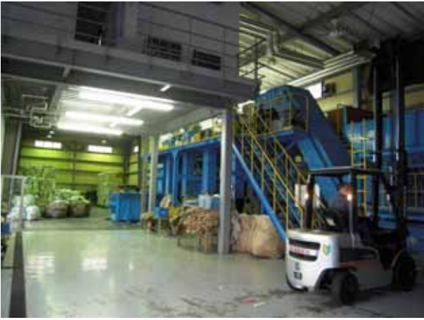
処理設備 全景
