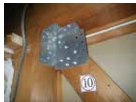
梁や柱と筋かいを固定します
