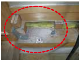
柱と土台を固定します
