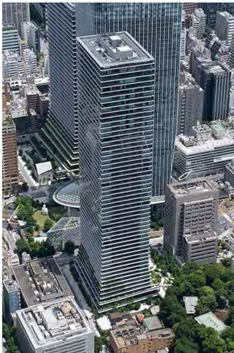
図2.3.2-4 俯瞰写真(計画地を南西側より望む)
