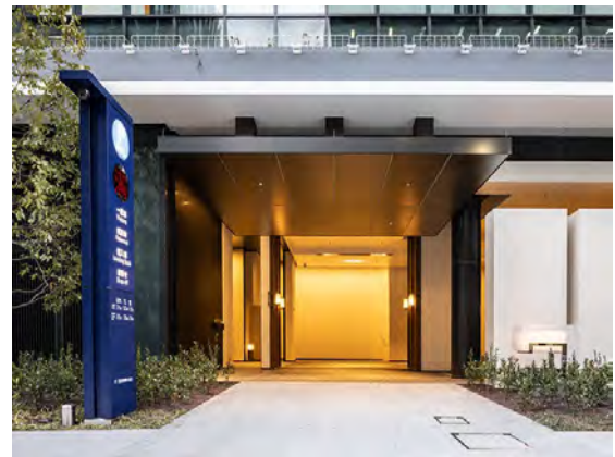
写真 4.1.5-2 駐車場入口案内看板の設置状況
