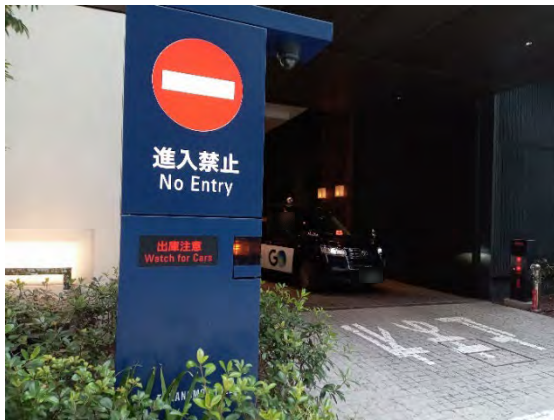
写真 4.1.5-1 駐車場出口の状況 (出庫ブザー、回転灯、路面標示)
