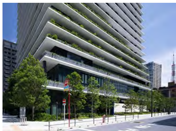
写真 4.3.2-3 外壁部の庇及びデッキ上部の緑化状況
