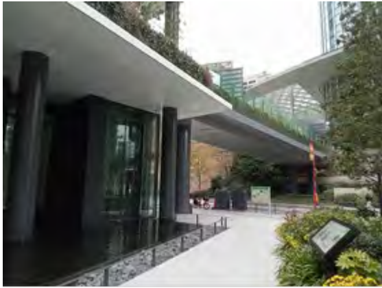
写真 4. 17. 2-1 商業施設と繋ぐ歩行者デッキ
