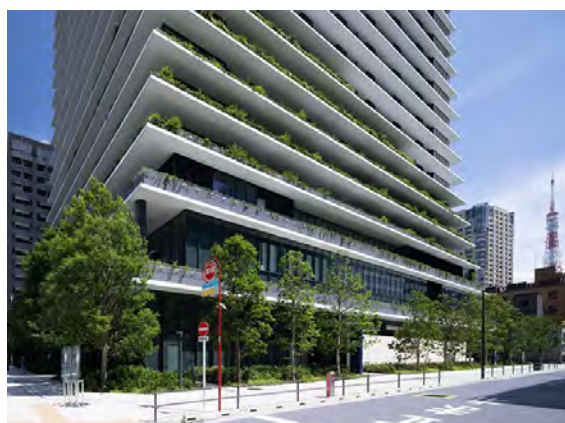
写真 4.13.3-1 低層部の壁や庇の設置状況
