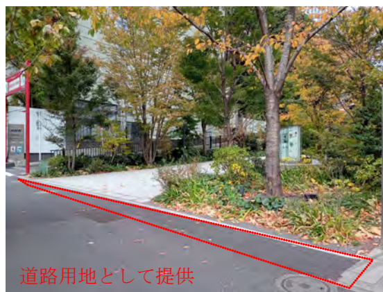
写真 4. 1. 1-1 道路用地の提供状況
