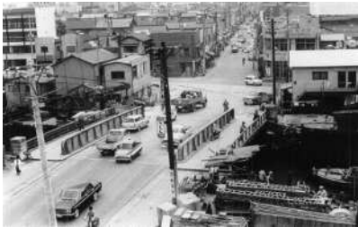
将監橋（古川改修工事） （昭和 38（1963）年） （港区立郷土歴史館所蔵）
