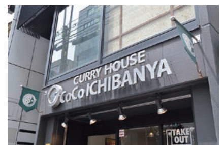
建築物のデザインや街並みに合わせて規模や色彩等を調整した壁面広告物の例
