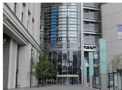
建築物の外観全体と調和するよう位置や色彩等を調整した懸垂幕の例
