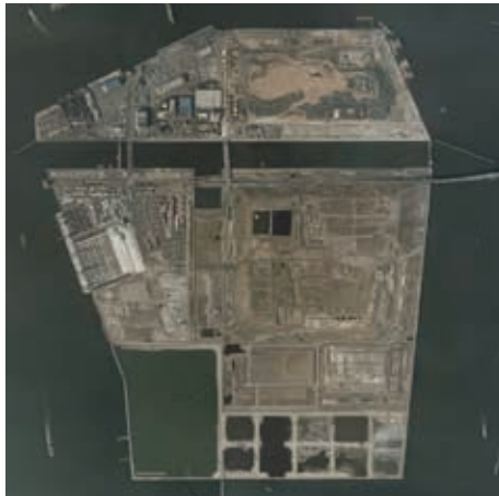
▶ 中央防波堤埋立処分場の様子
