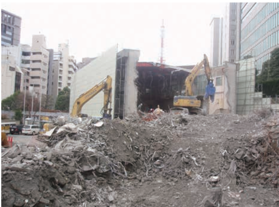
▶ 解体工事の様子
