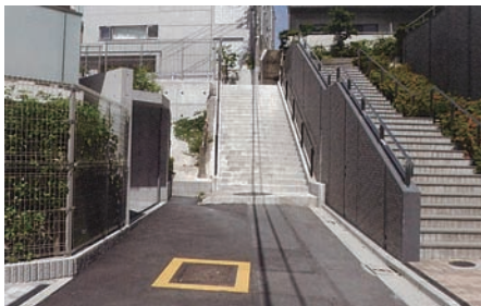
細街路が拡幅された後
