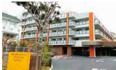
南麻布四丁目福祉施設外観
