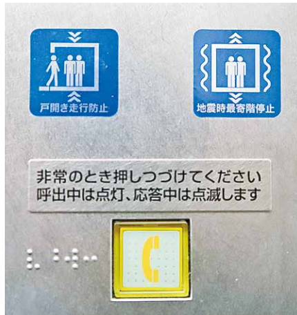
エレベーター安全装置設置済みマーク (青いシール)
