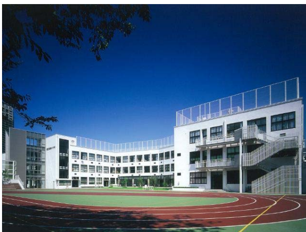
高輪台小学校（昭和 10（1935）年竣工）
