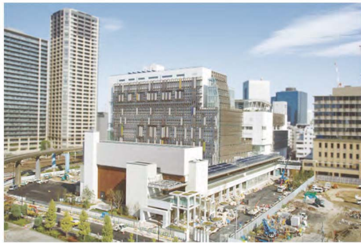
田町駅東口北地区のみなとパーク芝浦が平成26年12月に開設 (出典:港区ホームページ)
