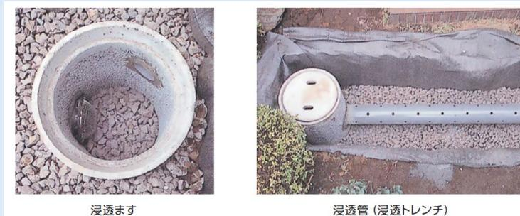
図 5-28 雨水浸透施設の例
