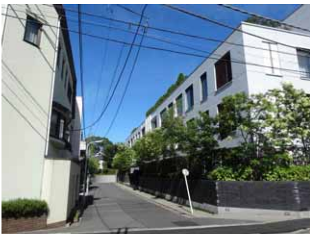
建物周囲や屋上を緑化したマンションの例（南麻布3丁目） 低層マンションでは屋上緑化の効果は高いものとなっています。
