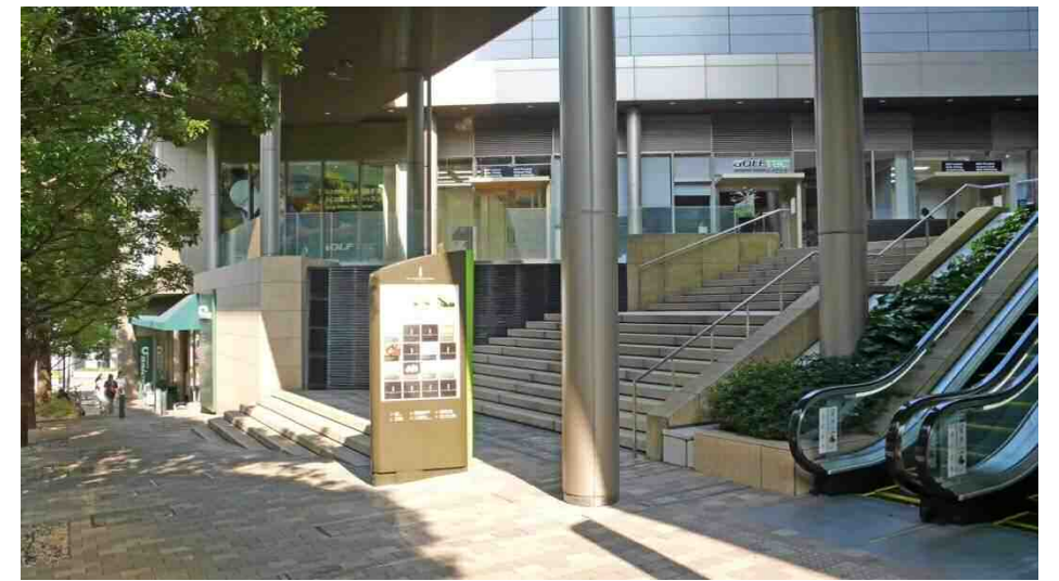
北側からの写真
