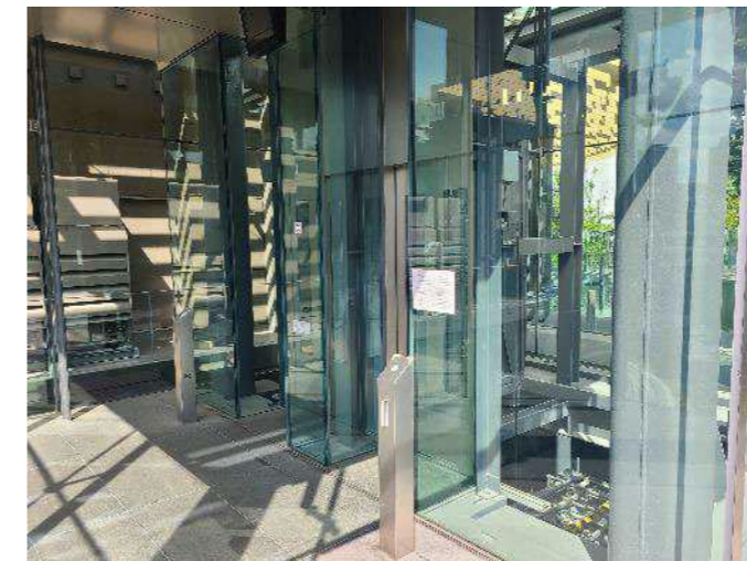
歩行者通路4号 (エレベーター)
