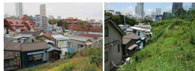
緩傾斜化や安全な擁壁に整備することが求められている、急傾斜地崩壊危険箇所として公表されている斜面地に面して建つ住宅
