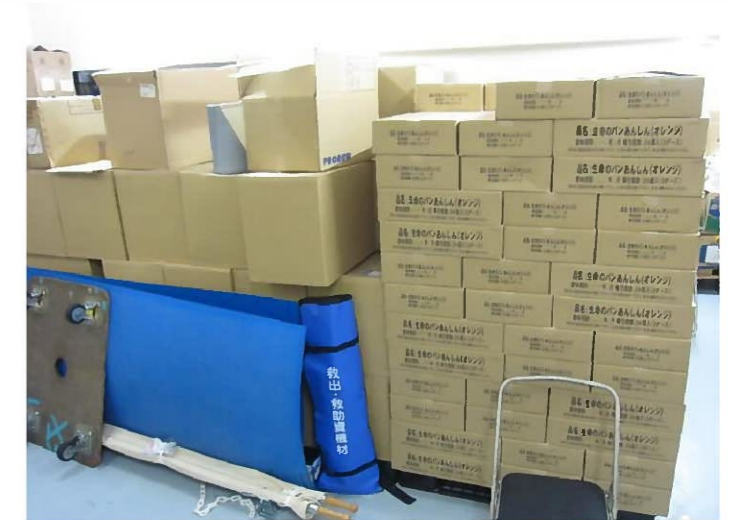
地下階の防災備蓄倉庫
