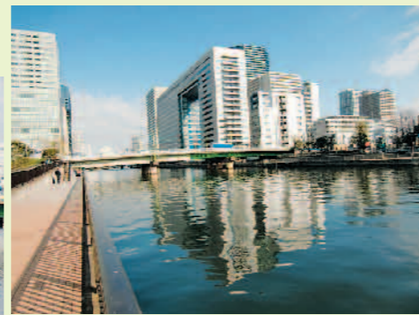
(橋は現在塗装中で、3月下旬完成予定です)
