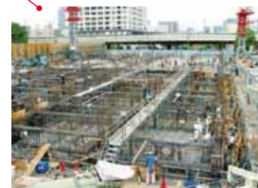
港南小学校建設工事現場
