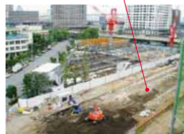
都市計画道路補助123号線工事現場
