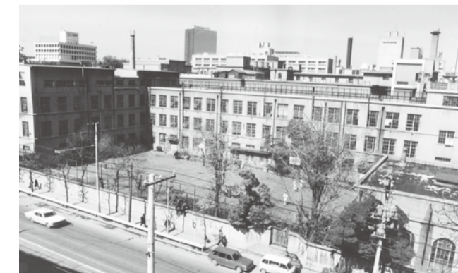
旧愛宕中学校校舎(写真提供:御成門中学校)
