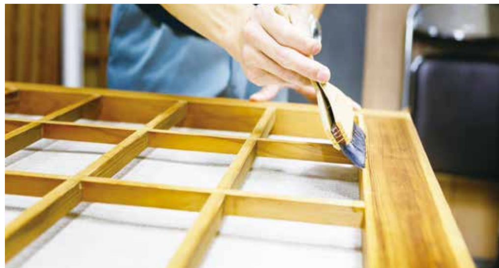
細やかな作業で進められる障子の張替
