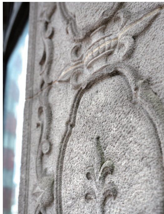
建物外壁タイル
