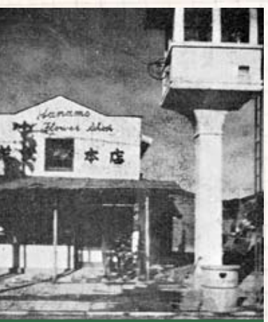
終戦後の店舗、右手前の高見台は「信号塔」です。都電の職員である信号担当者がここから換車をしていた
