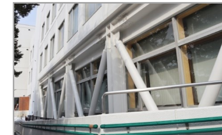
耐震補強工事を行った建築物
