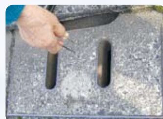
雨水マスに錠剤を投入。
