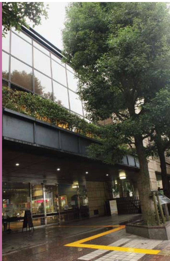
麻布地区総合支所
